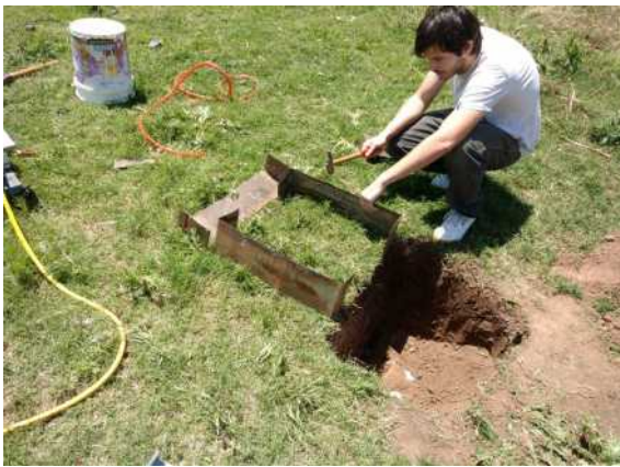
Figura 5. Excavación del pozo de medición e hincado de chapas laterales.
